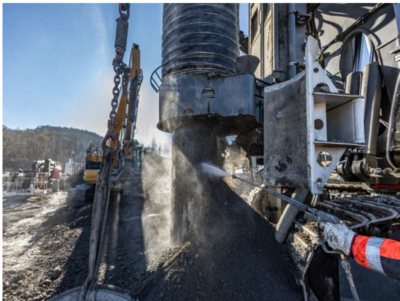
Fot. Wykonywanie wierceń pod pale na budowie S19, (u góry) film zrealizowany przez GDDKiA pokazujący pracę wiertnicy.
