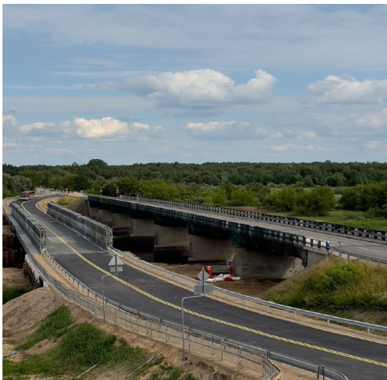
Fot. Ukończona przeprawa tymczasowa przez Narew.
