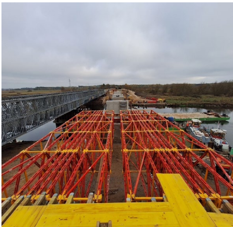
Fot. Montaż kratownic Alphakit.
