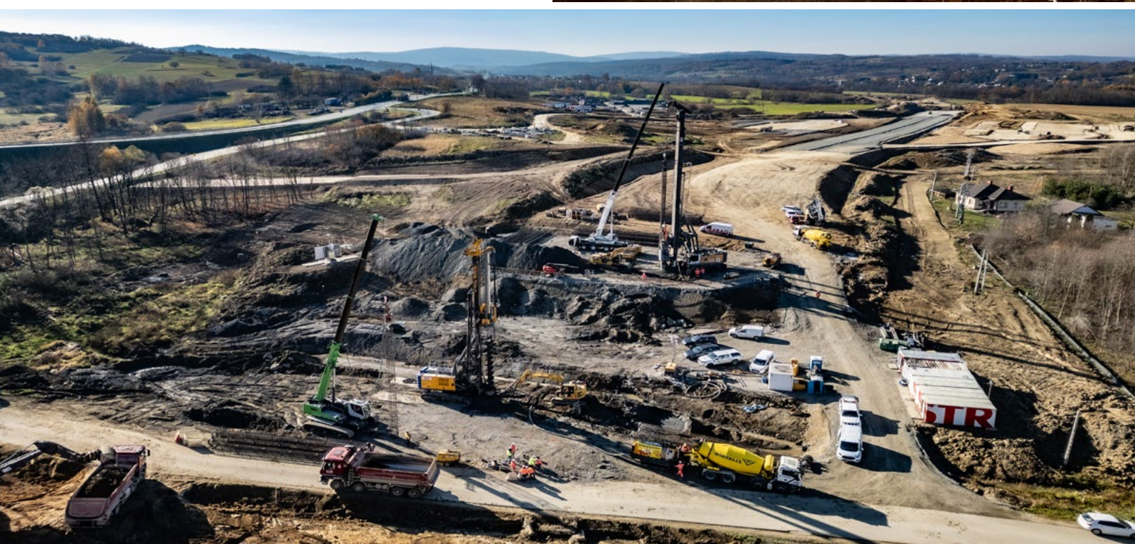
Fot. Liebherr LB44 na budowie S19.
