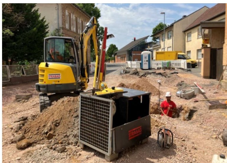
Fot. mobilna skrzynka narzędziowa ze standaryzowaną zawartością (podręcznych narzędzi i sprzętu BHP) i możliwością transportu na zawieszaku lub za pomocą chwytaka widłowego.
