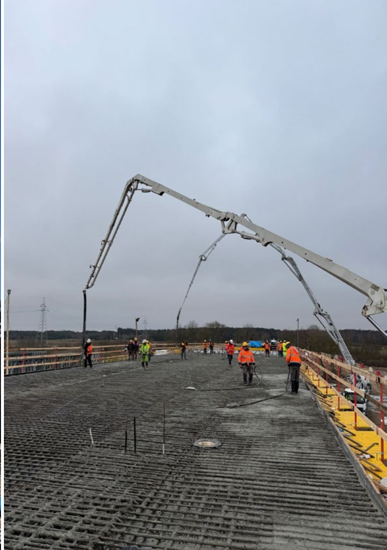
Fot. Palownica pracująca przy podporze nurtowej (po lewej) oraz betonowanie ustroju niosącego mostu (po prawej).
