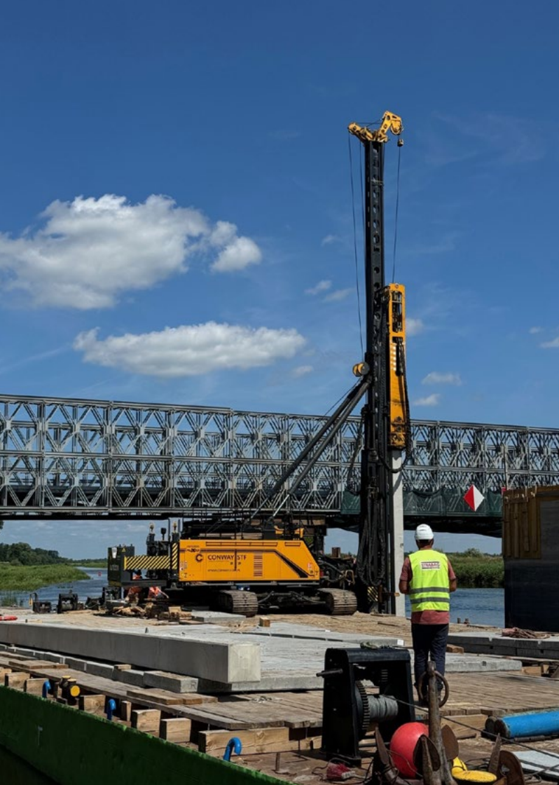
Fot. Palownica pracująca przy podporze nurtowej (po lewej) oraz betonowanie ustroju niosącego mostu (po prawej).
