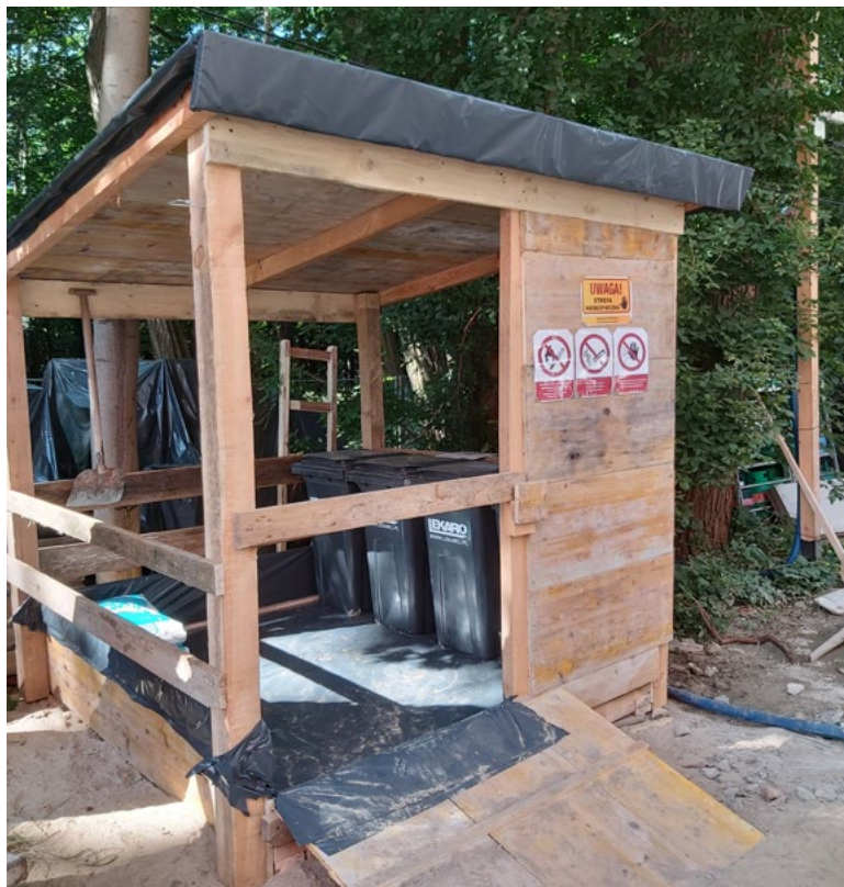
Fot. (u góry) tablica „+6 Frakcji w akcji” na budowie oraz (na dole) wiata skonstruowana przez pracowników na budowie Szpitala Bielańskiego w Warszawie specjalnie do kontenerów na odpady niebezpieczne- zapewnia pełne zabezpieczenie przed przedostaniem się substancji niebezpiecznych do gleby.
